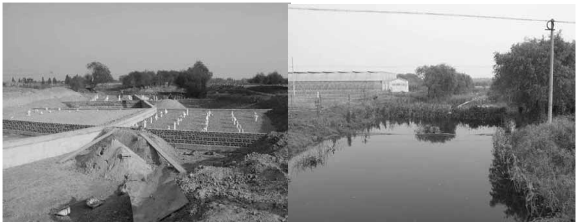
写真 2 太湖へ流入する河川の浄化施設：左が河川の一部にれきを充填する工事の様子(2004年11月)、右が河川水の導入後の様子(2005年9月)(筆者が江蘇省宜興市郊外で撮影)
