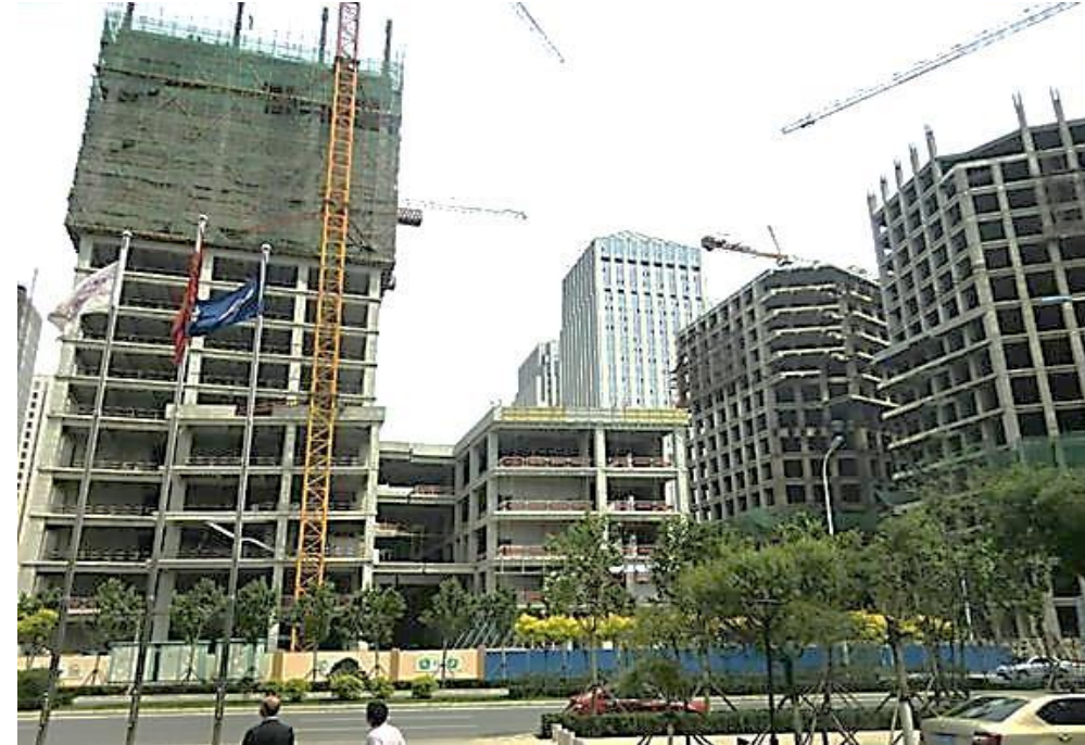
建設中のビル(5/21) 濱海新区中心商務エリア
