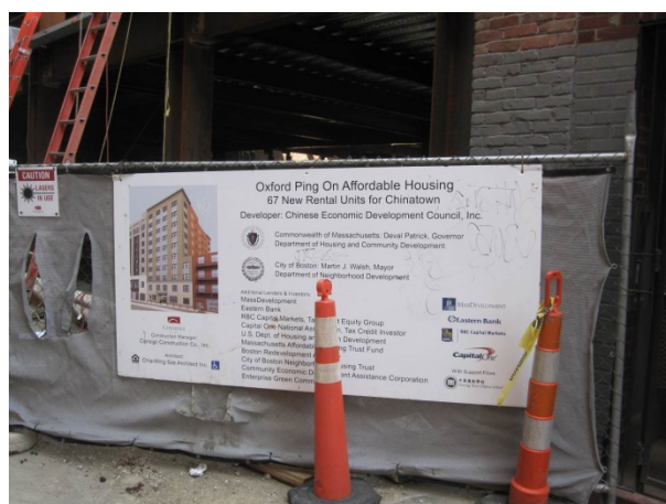
図7 オックスフォード平安アフォーダブル住宅の工事現場
